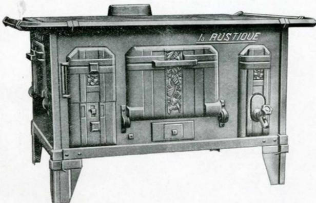
Le dessus est à intérieurs mobiles. La buse de départ de grande section assure un tirage parfait, et peut se placer sur l'appareil ou derrière.
